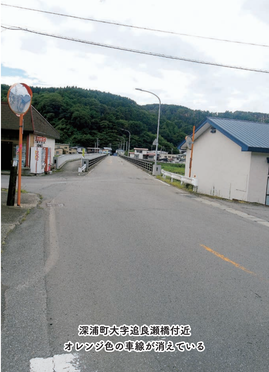
深浦町追良瀬橋を前後しての区間
